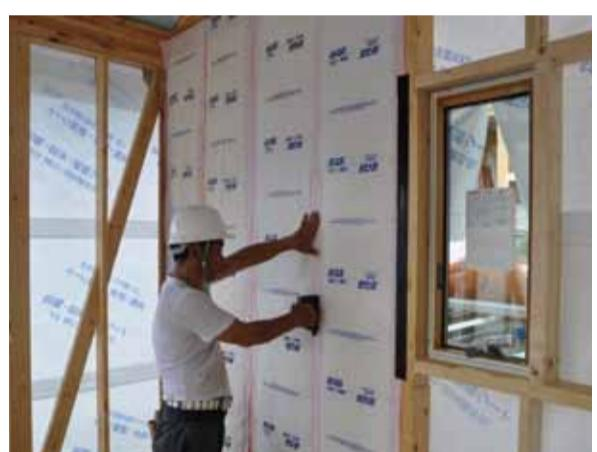
断熱材は高性能グラスウール断熱材eキュー<sup>ズ</sup>を採用した。施工性の高さが採用の理由の一つ。写真はeキュー<sup>ズ</sup>を充填し、重ね合わせ耳を固定している様子。
