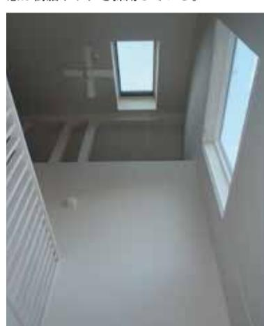
暑さ対策として、暖められた空気の排出に配慮し、必ず天窓を設定している。
