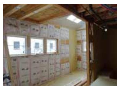
充填断熱にはeキューズを採用している。窓は樹脂サッシを採用している。
