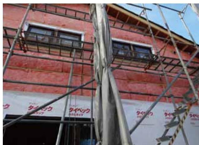
200mm断熱とするために、外側に100mmの付加断熱を施工している。
