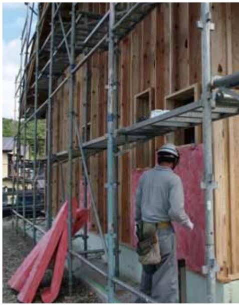
200mm断熱は次世代基準仕様の外側を100mmの断熱材で包み込む
